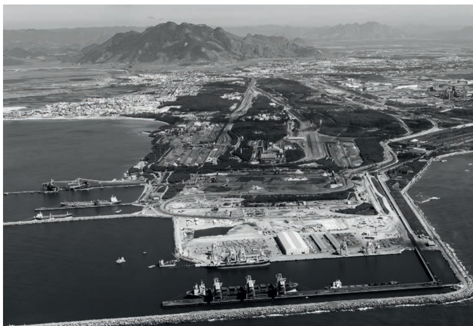
Vista panorâmica do Complexo de Tubarão, em Vitória, inaugurado em 1966. Data: 1968. Autor: Não identificado. Acervo: Museu Vale do Rio Doce.
